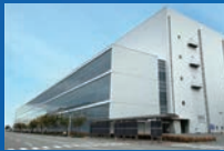
積水ソーラーフィルム堺工場 (2027年稼働予定)
